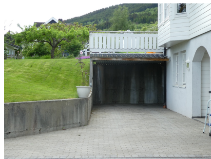
Rekkverk på søttemur
