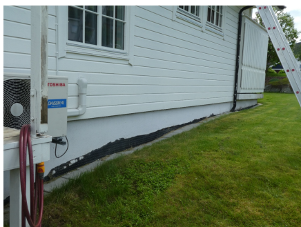
Synlig knotteplast i nordøstfasaden
