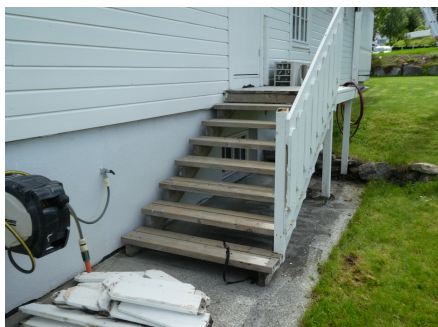
Trappen er under rehabilitering
