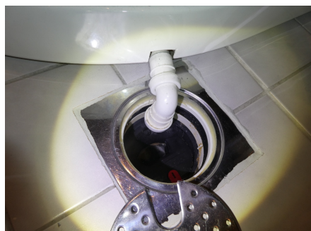
Sluk foran dusjkabinettet
