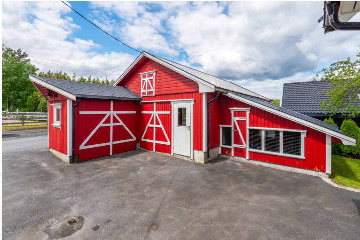
Garasje og verksted.
