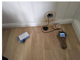
Kontroll i lukkede konstruksjoner -
