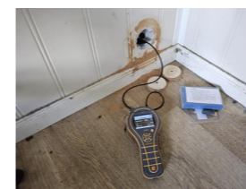
Utført kontroll i tilliggende konstruksjon - .
