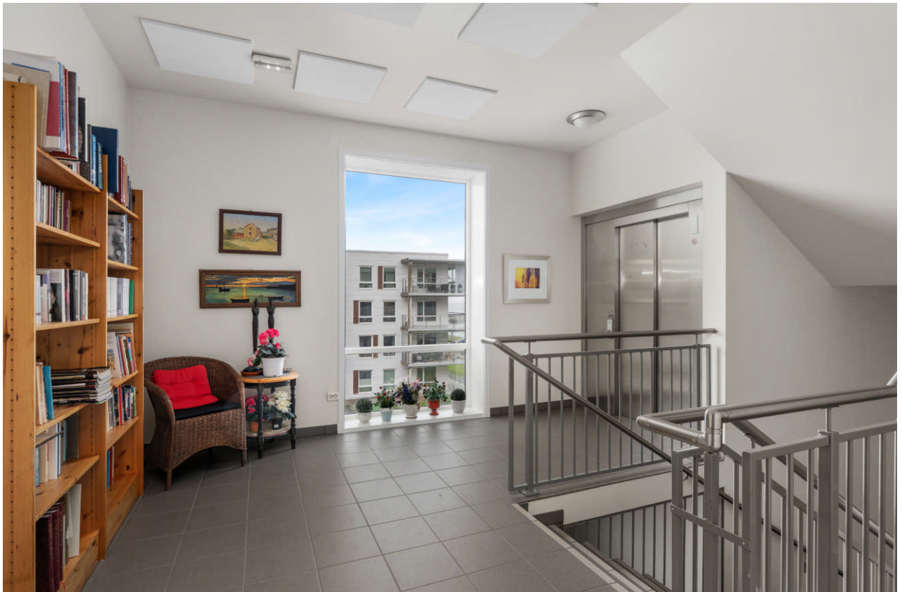
Heis i bygget
