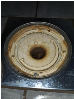
Vanntett sjikt / membran i gulv og vegger - Sluk bad hybel-del
