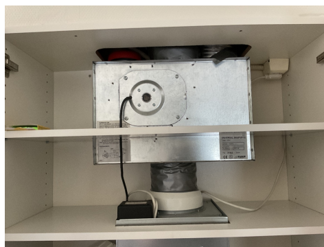
Mekanisk avtrekksenhet.
