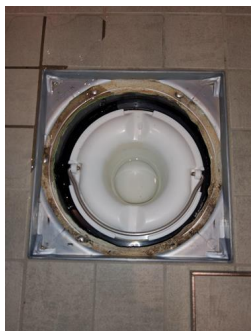
Tettesjiktets tilslutning til sluk - Sluk dusj bad
