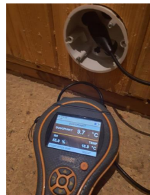
Utført kontroll i tilliggende konstruksjon - Fuktmåling.
