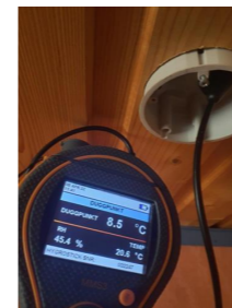
Utført kontroll i tilleggende konstruksjon - Fuktmåling.
