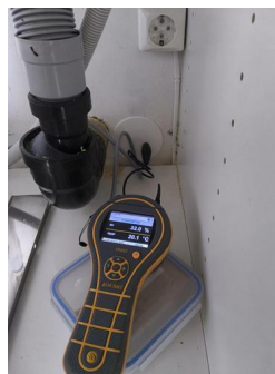
Utført kontroll i tilliggende konstruksjon - Fuktmåling
