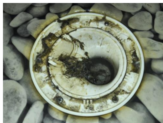
Tettesjiktets tilslutning til sluk - Sluk
