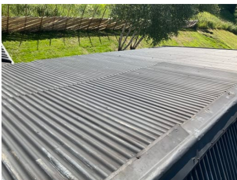
Tekkingen er besiktet oppe på taket
