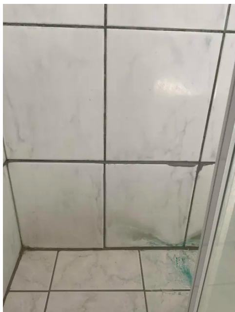
Utbedringer av fuger utført med mykfug
