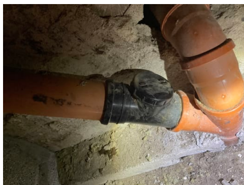
Stakeluke med adkomst via kjeller
