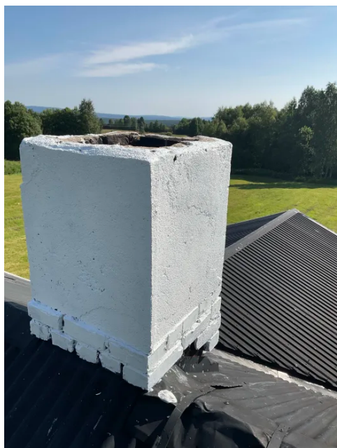
Innvendig ett-løps teglpipe
