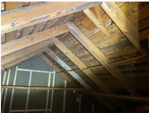
Adkomst til kaldtloft via loftrom
