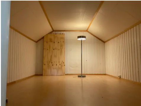
Loftetasje med innvednige skråhimlinger
