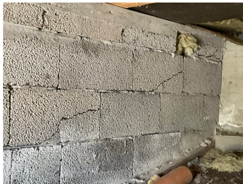
Grunnmur med tegn etter jordtrykkskade
