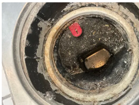
PVC-sluk med stakemuligheter
