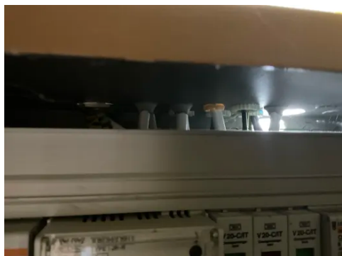
Utett sikringsskap
