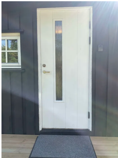
Malt terrassedør med isolerglass
