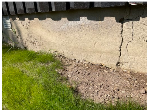
Grunnmur med tegn etter jordtrykkskade
