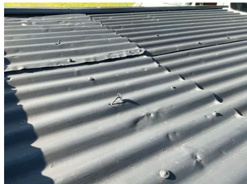
Taktekking med spikeropptrekk
