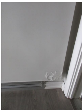
Skade nederst på kjøleromsdør.
