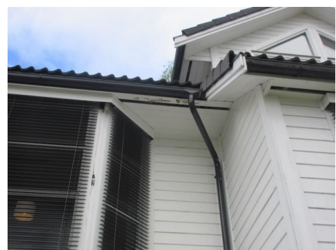
Utvendig gesims ved siden av karnapp
