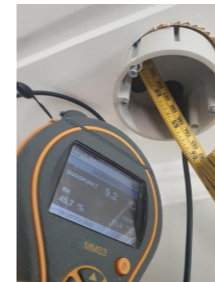
Utført kontroll i tilliggende konstruksjon - Fuktmåling.
