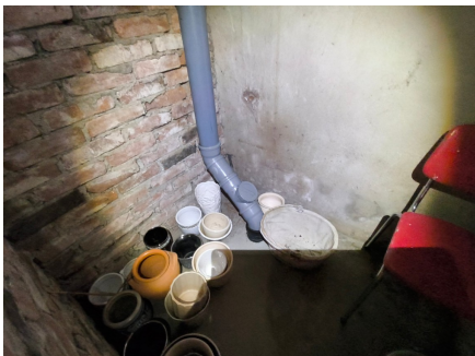
Stakeluke etablert i kjeller.
