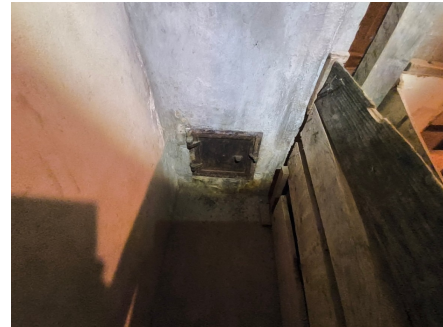
Sotluke montert i kjeller.
