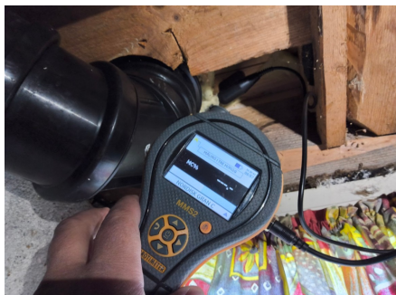
Ved fuktmåling ble det registrert tørre verdier.
