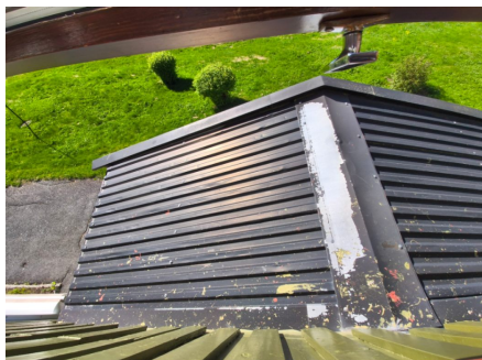
Flassing på overflate.
