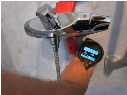
Ved bruk av fuktindikator på utsatte steder registrerte jeg ingen unormale verdier.
