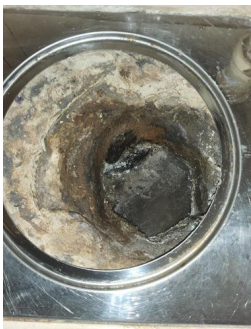
Tettesjiktets tilslutning til sluk - Sluk
