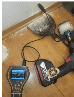
Utført kontroll i tilliggende konstruksjon - Fuktmåling
