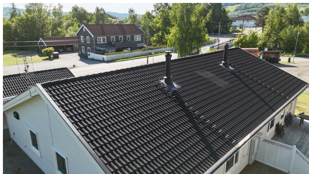
Oversiktsbilde av taktekingen.
