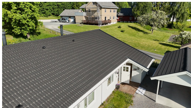
Oversiktsbilde av taktekingen.
