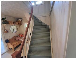
Rekkverk og håndløper - .
