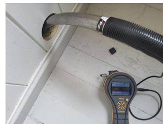
Utført kontroll i tilliggende konstruksjon - .
