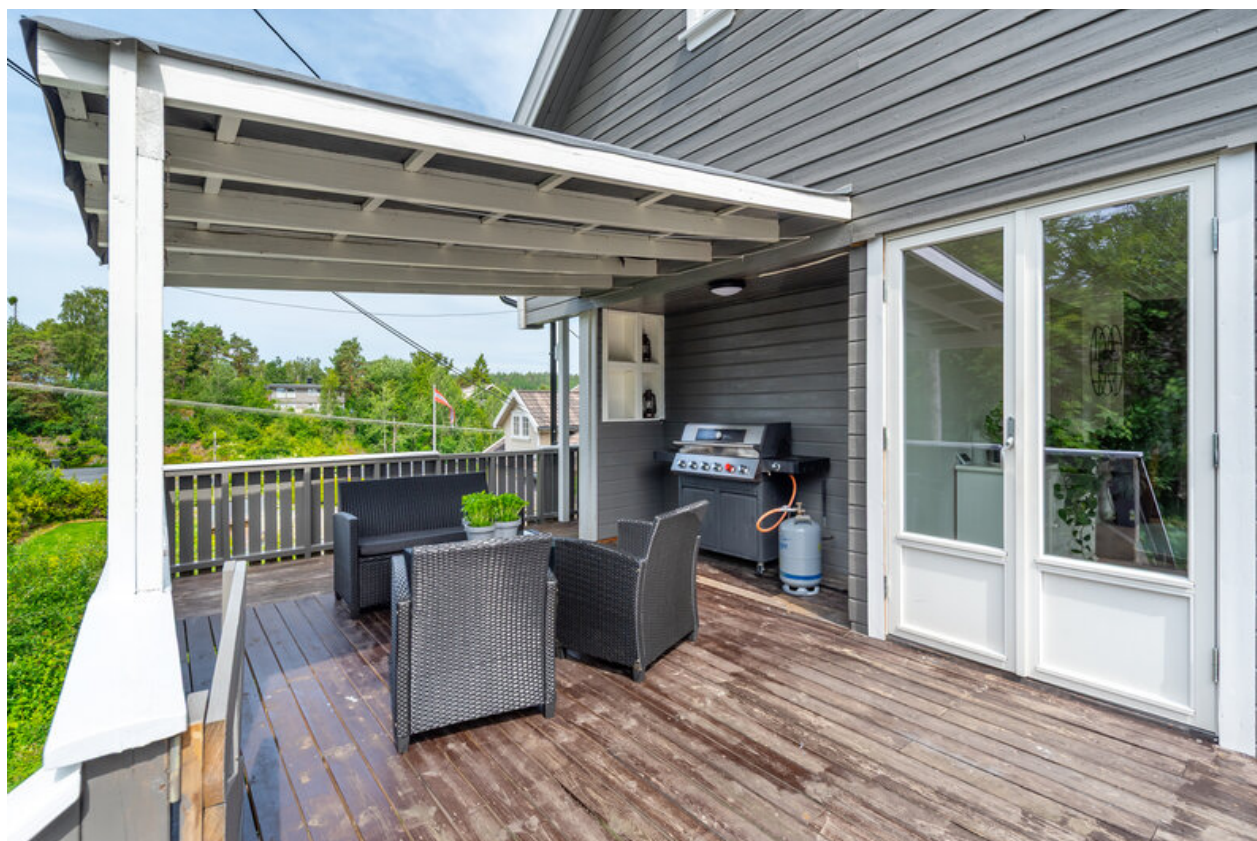
Delvis overbygget terrasse.
