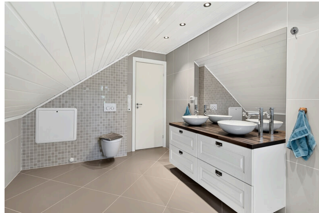
Vegghengt toalett, varmekabler i gulv og downlights i tak.
