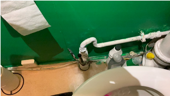
Stoppekran i toalettrom.
