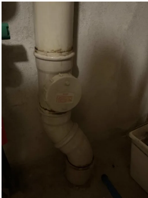
Stakeluke på hovedavløpsstamme i kjeller
