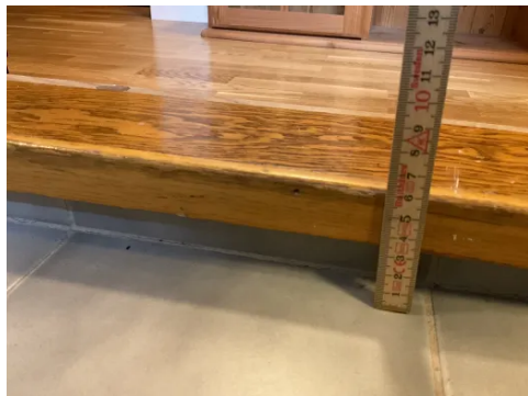
Etablert fuktsikring ved dør
