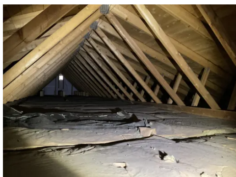
Takkonstruksjon utført med pre-fabrikerte sperrer
