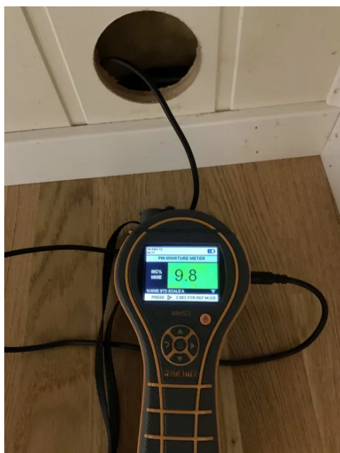
Fuktsøk med hulltaking, ingen unormale verdier
