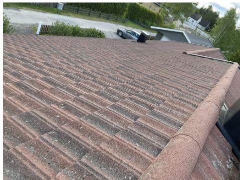
Taktekkingen er besiktet oppe på tak
