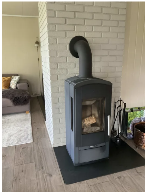
Ildsted med vedovn stue 1.etasje
