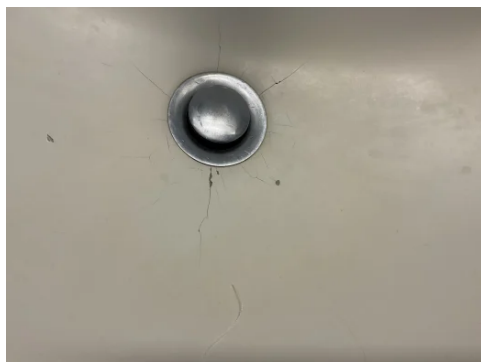
Servant med krakkeligsskader
