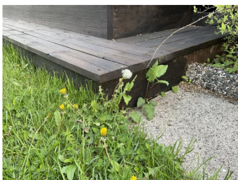
Ligger på terreng og utsatt for fuktopptrekk
