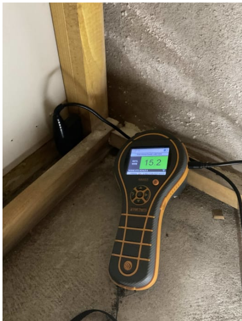
Fuktsøk innredning i kjeller, ingen unormale verdier
