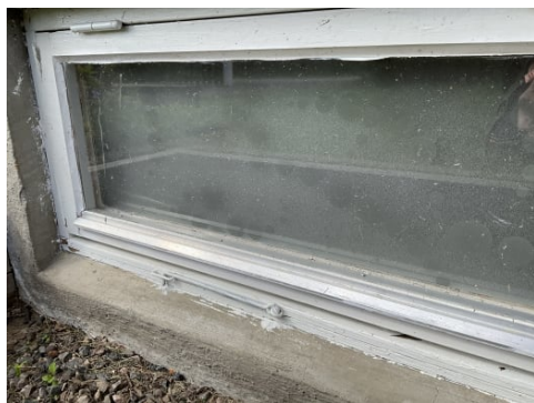
Kjellervinduer fra opprinnelig byggeåe
