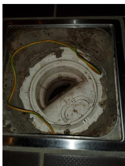
Tettesjiktets tilslutning til sluk - Sluk bad
