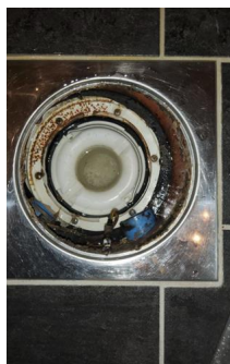
Tettesjiktets tilslutning til sluk - Sluk bad
