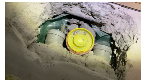
Nytt plastavløp lagt fram til teknisk rom kjeller
