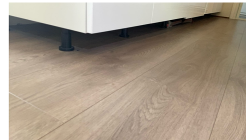
Gjenstående montering av sokkellist
