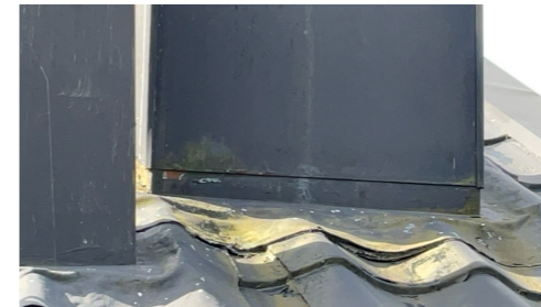
Korrosjon pipebeslag
