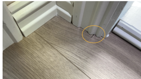
Sagespor i lamiantgulv
