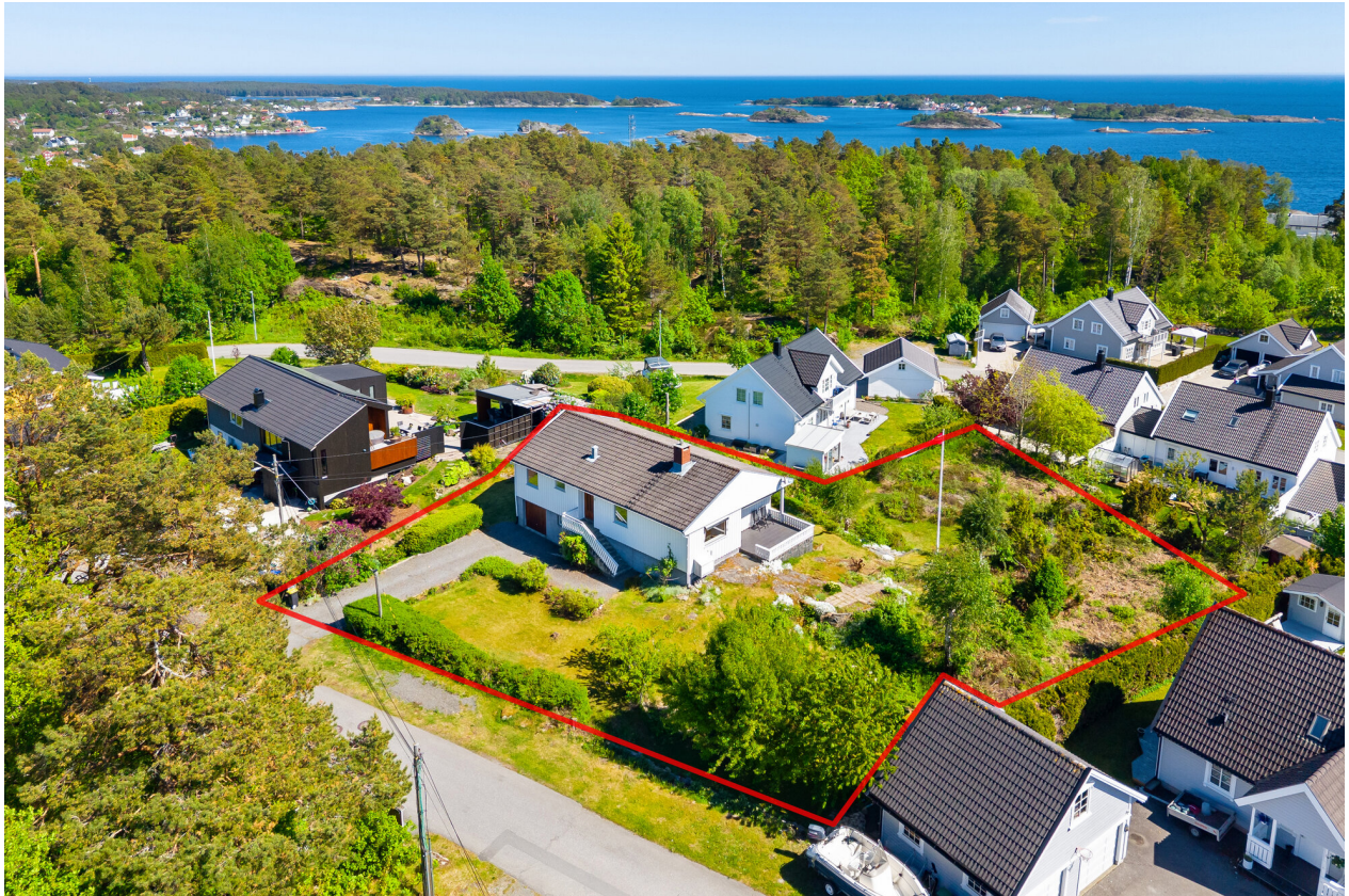
Oversiktsbilde av boligen og tomta.
