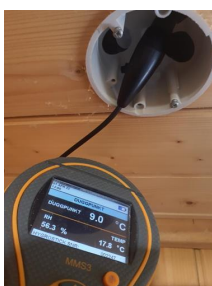
Utført kontroll i tilliggende konstruksjon - Fuktmåling.
