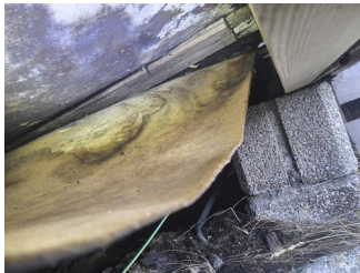
Annet - Løse plater i bjelkelaget
