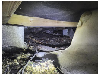
Annet - Løse plater i bjelkelaget
