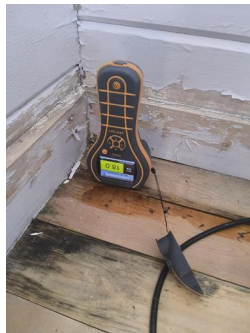
Innvendige forhold - Fuktmåling
