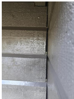
Innendige forhold - Åpninger i kledning
