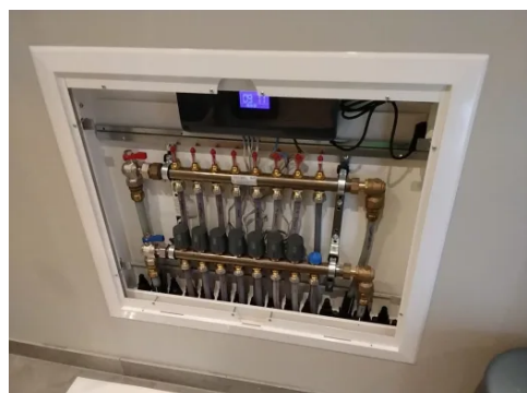
Vannskap for vannbåren gulvvarme.
