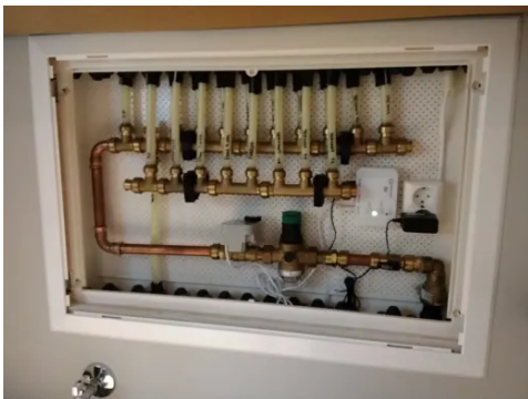
Vannskap for rør i rør system og stoppekran.
