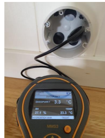
Utført kontroll i tilliggende konstruksjon - Fuktmåling.
