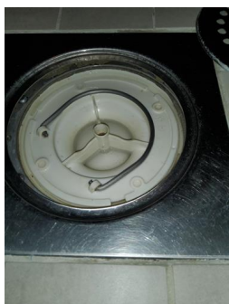
Tettesjiktets tilslutning til sluk - Sluk bad
