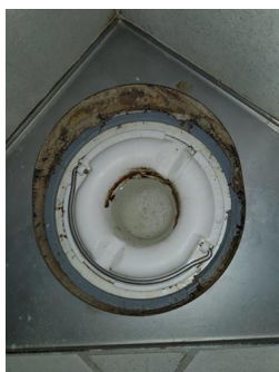
Tettesjiktets tilslutning til sluk - Sluk
