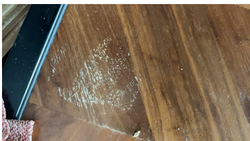
Slitemerker på benkeplate
