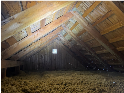
Innblåst isolasjon på loft
