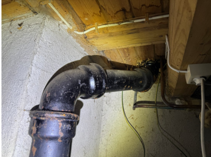
Støpejernsrør i kjeller
