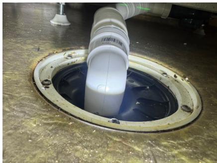
Bilde av sluk i rommet
