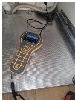
Utført kontroll i tilliggende konstruksjon - Fuktmåling
