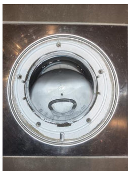
Tettesjiktets tilslutning til sluk - Sluk
