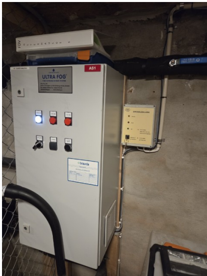
5306012 - Nøkkelbryter/alarmfunksjon settes i driftsposisjon
