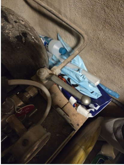
5306005 - Åpne testventilen forsiktig (test/dreneringsventil)
