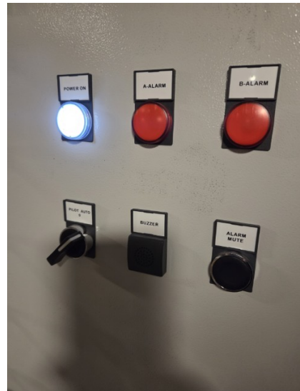
5306002 - Sjekk at startpanelet står i posisjon "automatisk"
