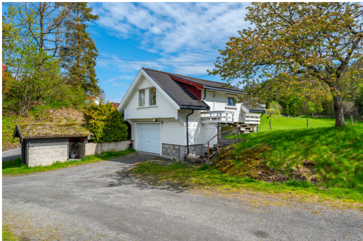
Garasje med innredet loft.
