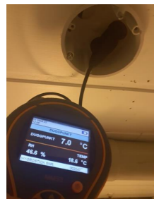
Utført kontroll i tilliggende konstruksjon - Fuktmåling.
