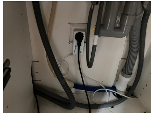
Vannstoppeventil i tilknytning til vask på kjøkken
