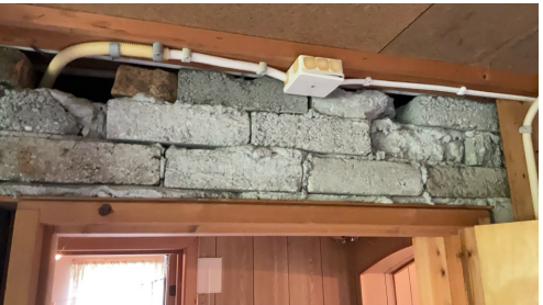
Kjeller, bod - dels gjenstående arbeid
