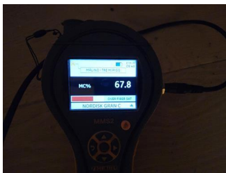
Kontroll i lukkede konstruksjoner - Fuktmåling utlektet kjellevegg.
