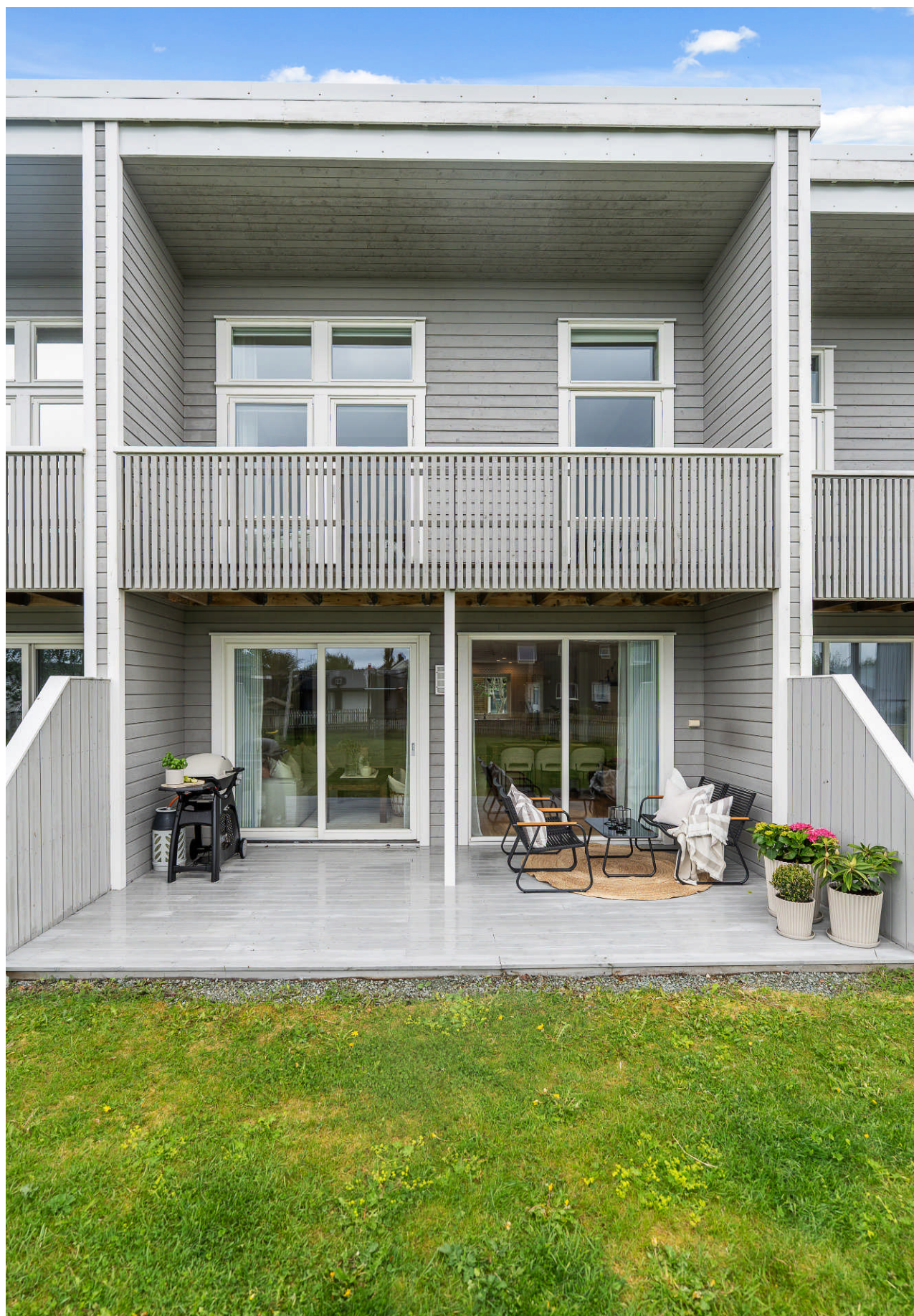
Terrasse og fasaden
