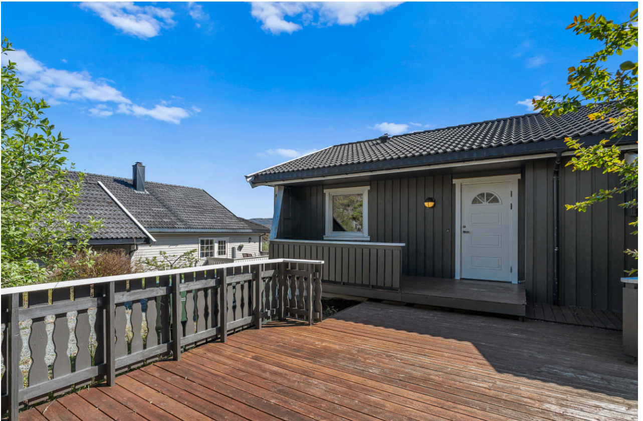
Inngangsparti med stor terrasse.
