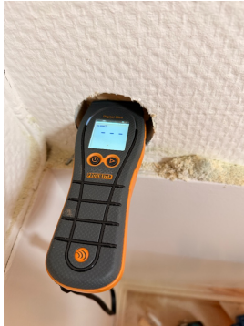
Fuktmåling i tilliggende konstruksjon.
