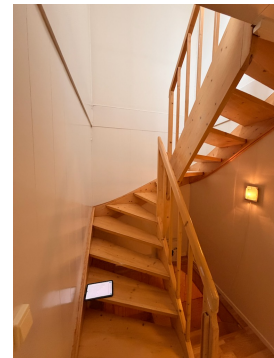
Trapp mellom 1. etasje og 2. etasje.
