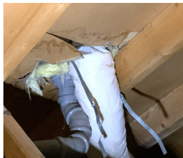
Gjennomføring for lufting
