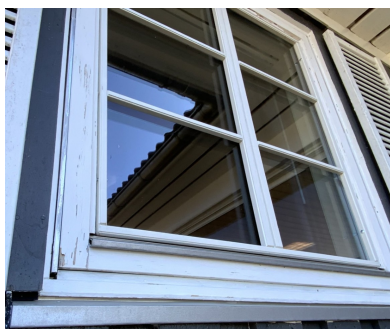
Eksempel på overflateslitasje.
