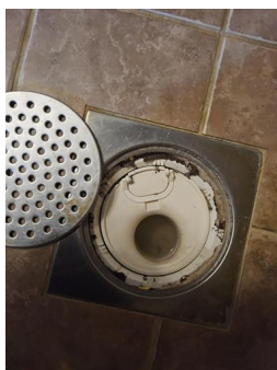
Tettesjiktets tilslutning til sluk - IMG_20260519_1
