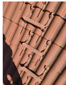
Tekking (med tilhørende beslag) - Knekte takstein bal stigeintrinn.
