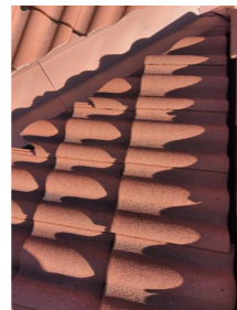
Tekking (med tilhørende beslag) - Knekte takstein og toppstein dekker ikke ned på takstein.
