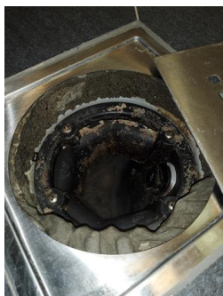
Tettesjiktets tilslutning til sluk - Sluk bad
