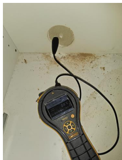
Utført kontroll i tilliggende konstruksjon - Fuktmåling bad
