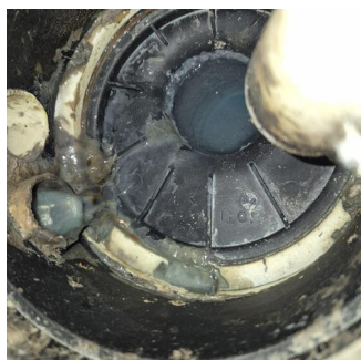
Tettesjiktets tilslutning til sluk - Sluk bad
