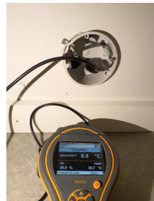
Utført kontroll i tilliggende konstruksjon - Fuktmåling.
