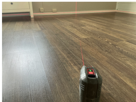
Nivellering soverom, avvik ca. 10-20 mm
