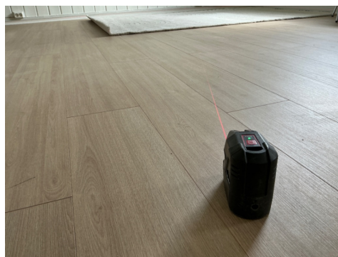
Nivellering stue/kjøkken i kjeller, ingen avvik registrert
