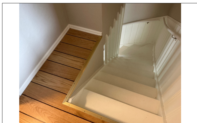
Manglende rekkverk i trapp ned fra loft
