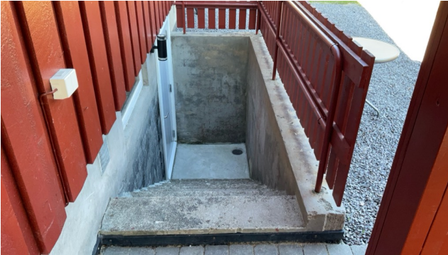
Utvendig kjelernedgang med støpt trapp.
