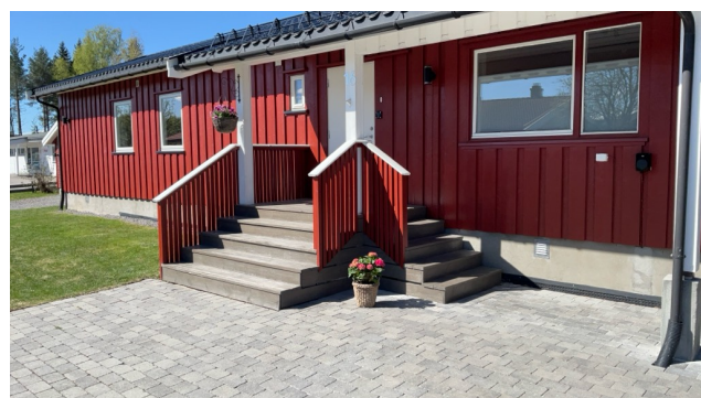
Overbygget inngangsparti med trapp. Platting på ca. 3 m2.
