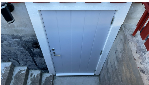
Inngangsdør til kjeller.
