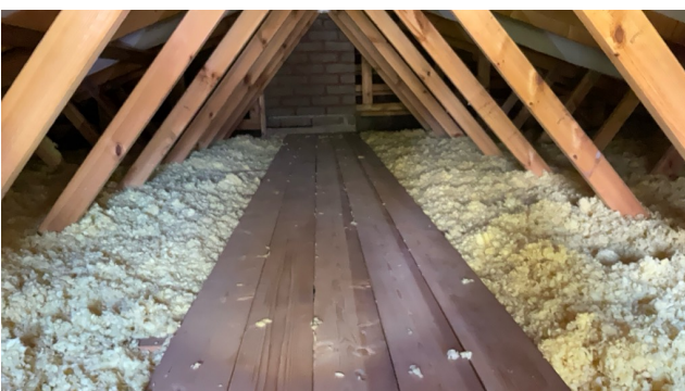
Tilleggsisolert med innblåst mineralull.
