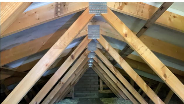
Spaltepanel under takutstikk for innluft.
