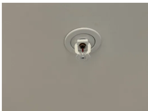
Bolig utført med sprinkelanlegg
