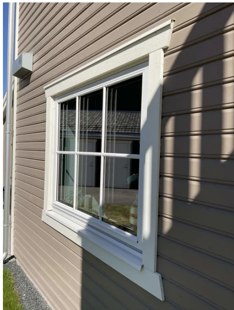
Utvendig vannbrett med metallbeslag
