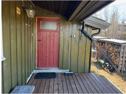
Ytterdør fra byggeår
