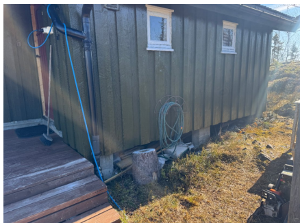
Punktfundamenter under gang, dorum og boder
