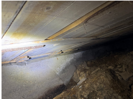
Oppklossing av bjelkelag på grunnmur observert fra krypkjeller
