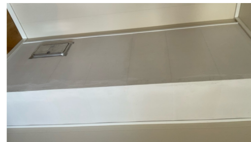
et er påvist sprekker og/eller riss i pipe.
