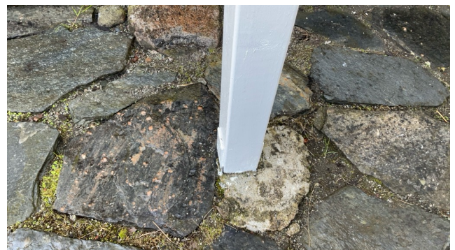
Søylene til balkong.
